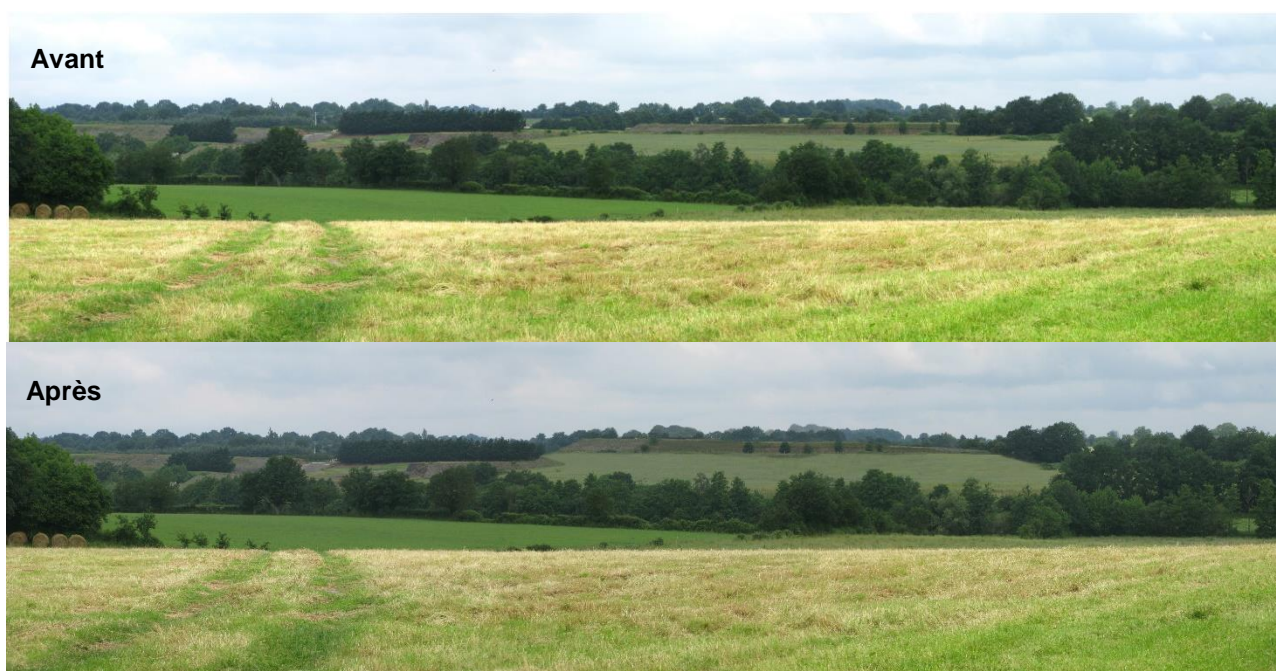
Figure 5 : Vue 1 actuelle depuis la RD 180, avant le projet de rehausse (haut) et après la remise en état (bas)
